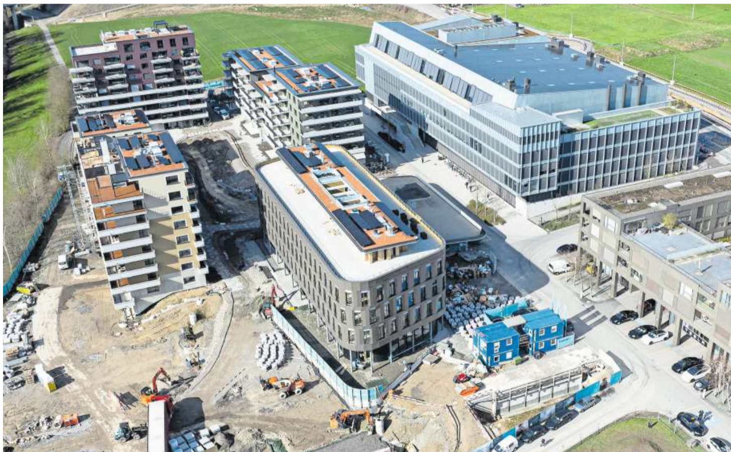
Im Gebiet Teuflibach neben dem OYM in Cham entsteht die Grossüberbauung Chama.
